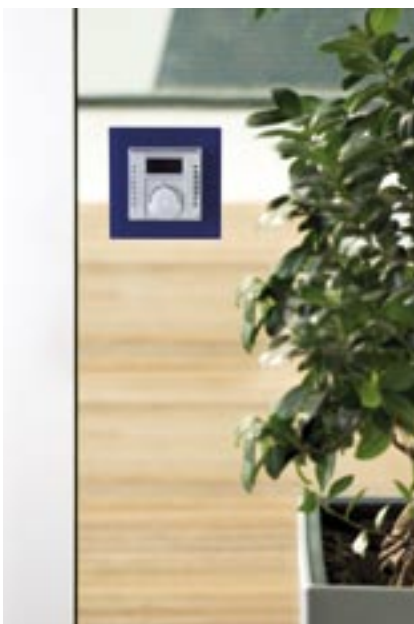
Montage am Fenster
